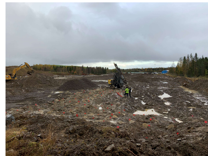
Borrning för sprängning av berg i närheten av tänkt svavelrening.
