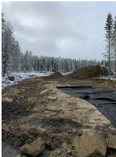
Uppbyggnad terrass infartsväg
