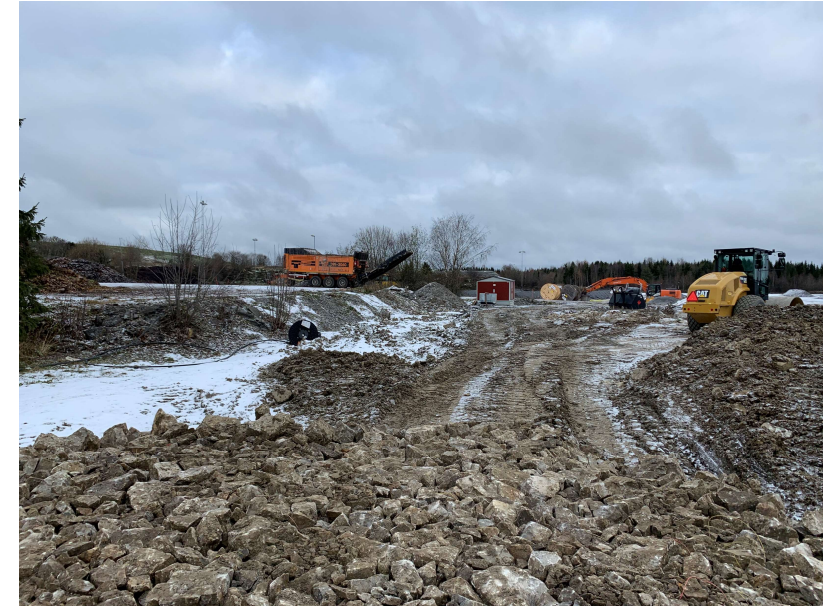
Uppfyllnad med bergkross vid kontorsbyggnaden. Riktning S
