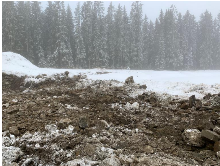
Schaktning av berg vid RRL
