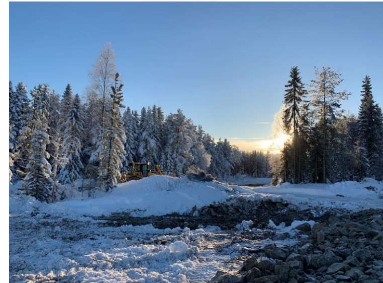
Utläggning av bergschakt vid utfart
