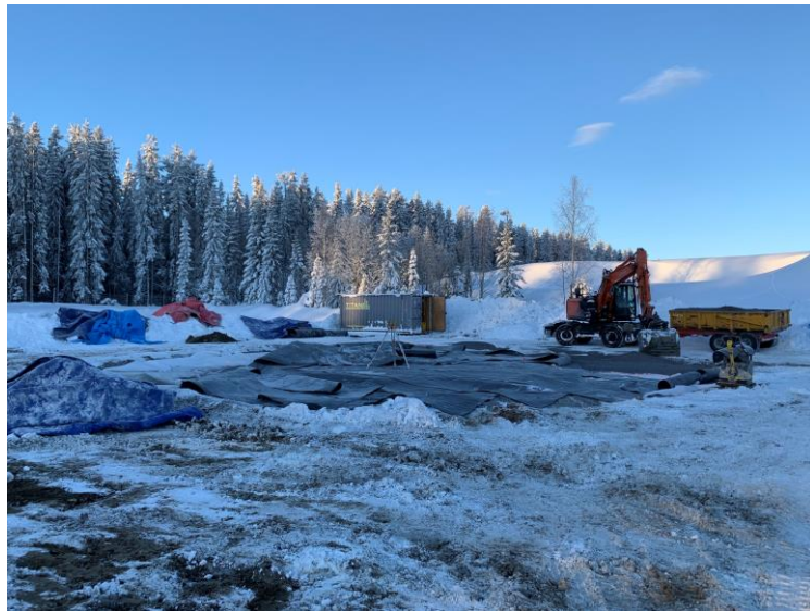
Arbeten med grundläggning RK1
