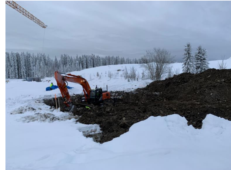
Schaktat för mottagningsficka
