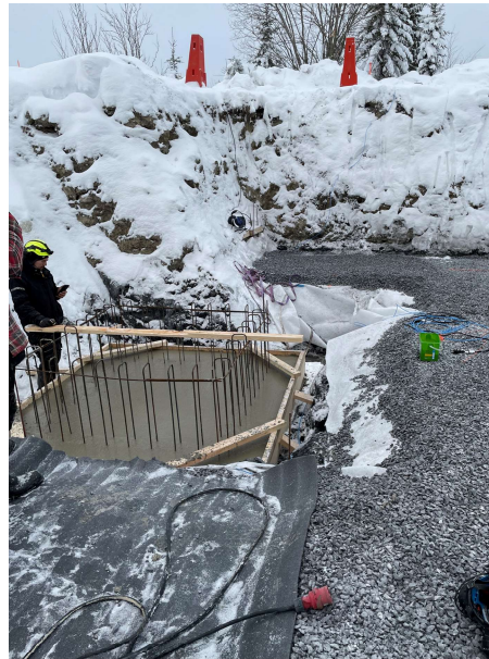
Gjutning av botten dränagebrunn
