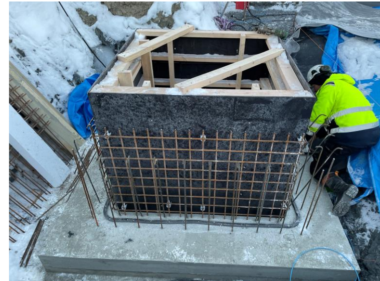
Formning och armering av dränagebrunn
