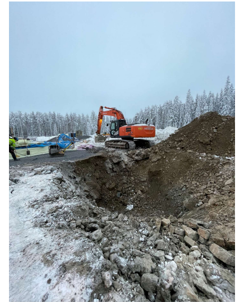
Schakt för kondensbrunn nr.1
