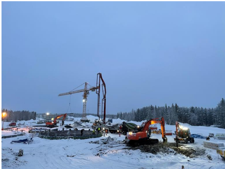
Gjutning RK2, schakt för RRL
