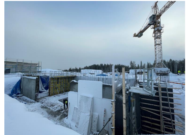
Formsättning och isolering av mottagningsficka
