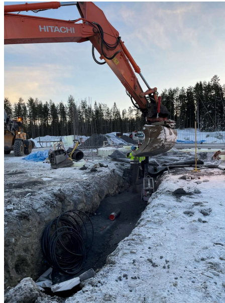
Förläggning tryckledningar RK2
