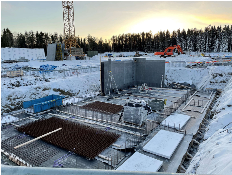
Bottenplatta och väggform mottagningsficka
