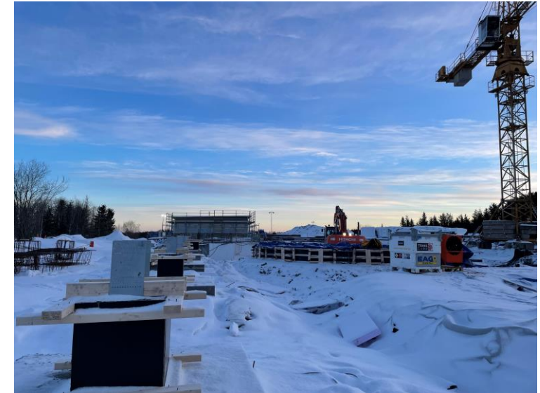
Plintar längs med processhallens långsida
