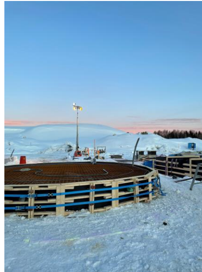
Inför gjutning av RRB
