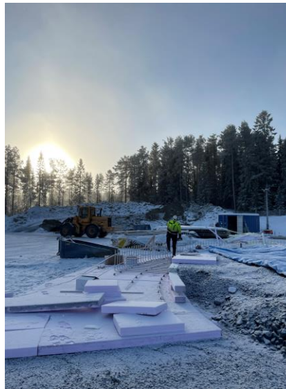
Isolering och armering av RRL
