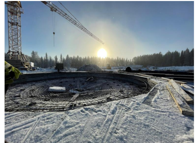
Armering av bufferttank flytgödsel
