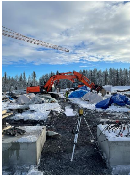
Ledningsbädd i processhallen
