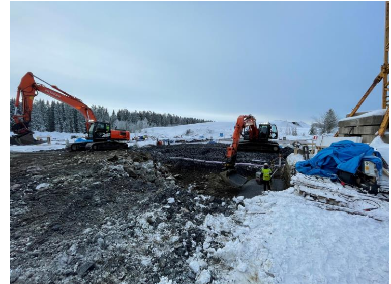
Schakt för mottagningstank flytgödsel
