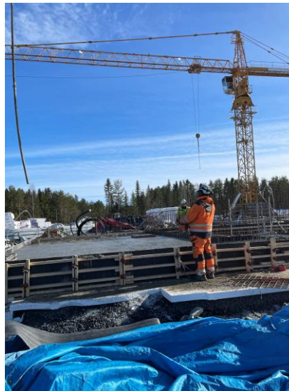
Gjutning av valv regnvattenlager
