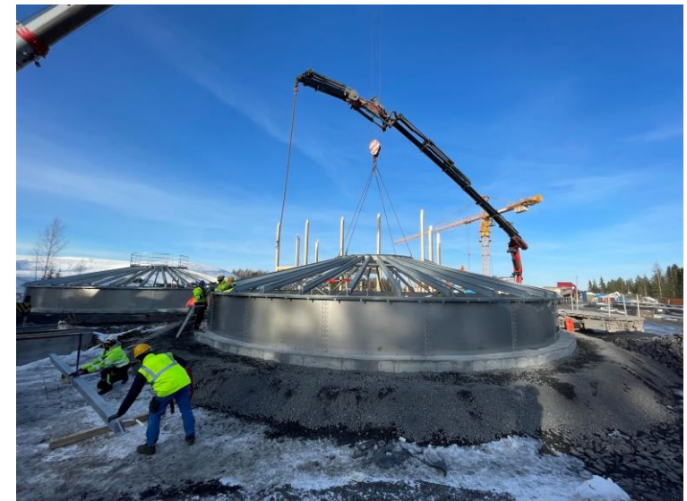
Montage av takbalkar vid RK2
