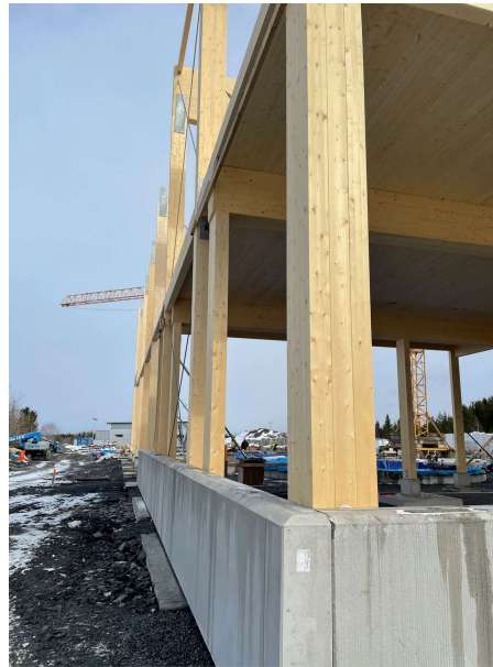
Montage av betongsockel
