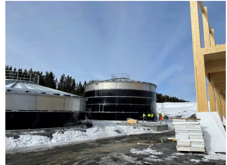
Montage av väggplåtar RK1
