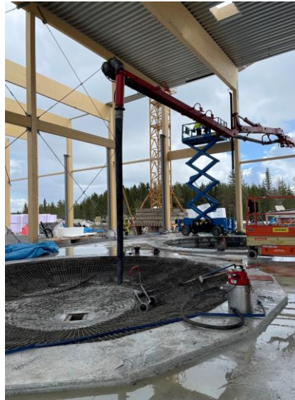
Gjutning av bufferttank flytgödsel
