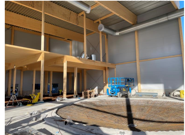
Installationsarbeten ventilation i processhall
