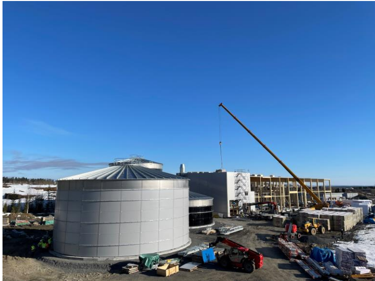
RRL närmast i bild, lyft av takmaterial pågår
