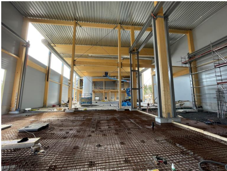
Armeringsmattor i förbehandling
