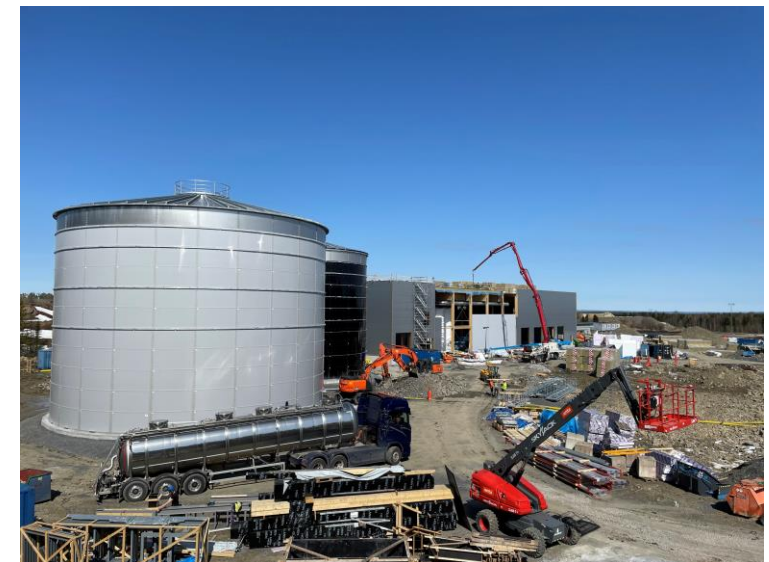
RRL till vänster, montering väggelement
