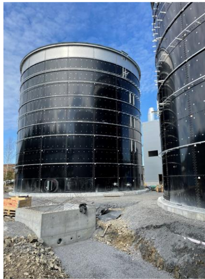
Ledningschakt kondensbrunn nr.1
