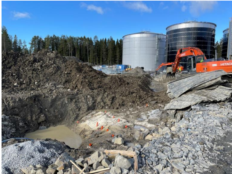
Ledningsschakt vid kondensbrunn nr.2
