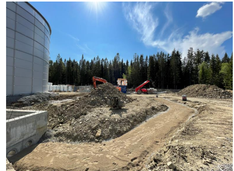
Ledningsschakt mot gasklocka
