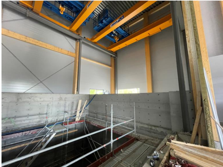
Väggar kring mottagningsficka
