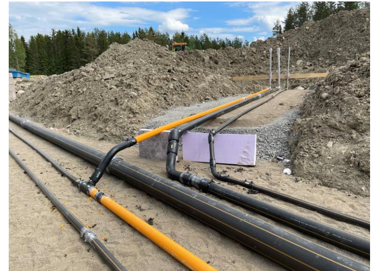
Gasledningar mot Hysytech
