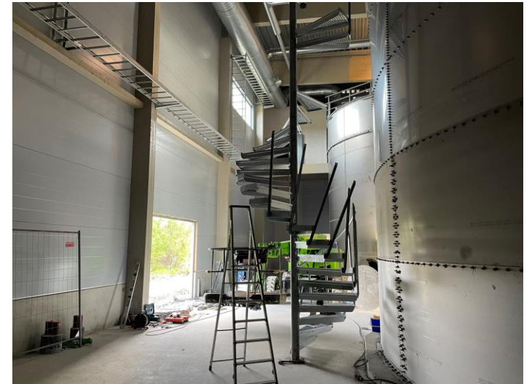
Montage av spiraltrappa Mejeritank
