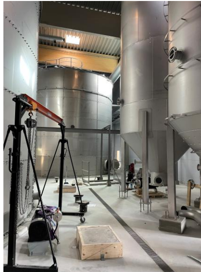
Montage av lyftbalkar i processhall
