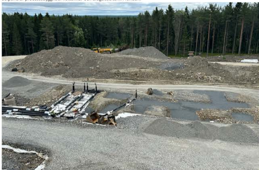
Underlag för betongplattor Hysytech.
