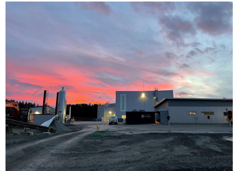
Hela anläggningen, bild tagen från öster
