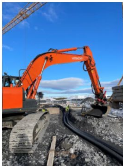
Förläggning av värmekulvert
