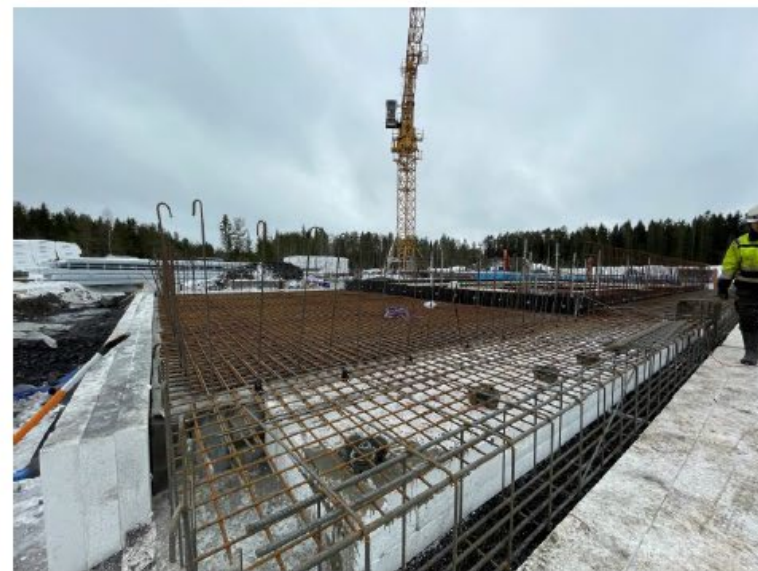
Armering av valv ovan regnvattenlager
